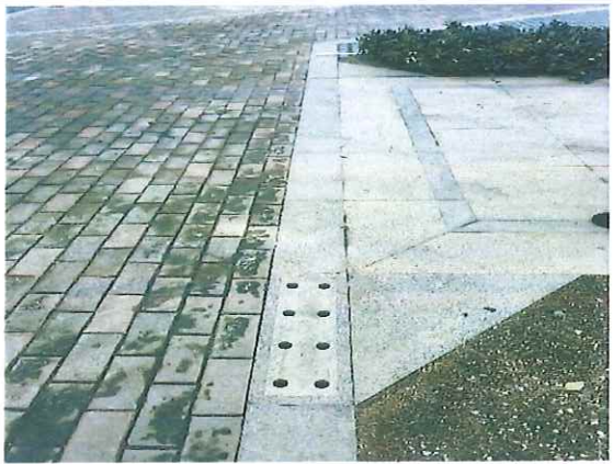
道路广场区排水沟
