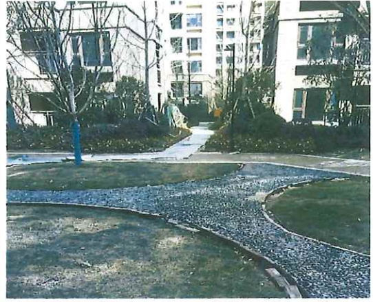
道路广场区透水路面
